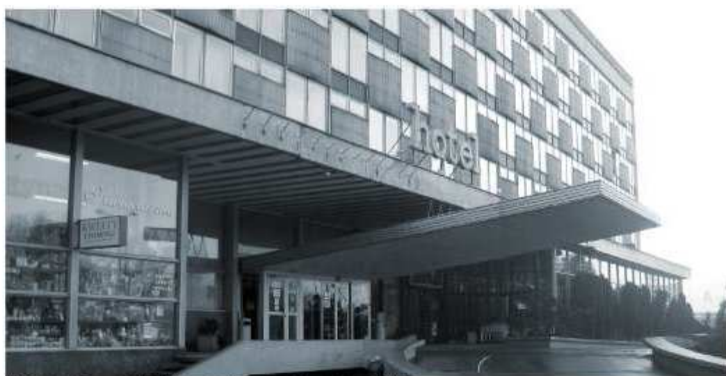
4.2.11 Hotel "Cracovia" i Kino Kijów, al.A.Mickiewicza/I.Krasńskiego (2011)
