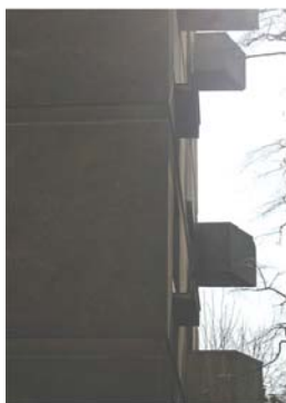
budynek mieszkaniowy-plomba, ul. Rajska
