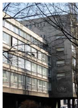
budynek biurowy Biprocemwap-u, ul. Morawskiego
