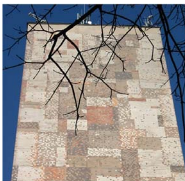
budynek Biprostalu, ul. Królewska
