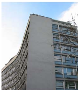
budynek biurowy Biproceiwop-u, ul. Morawskiego
