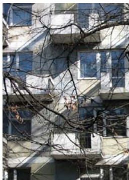
budynek mieszkalny, ul. Retoryka
