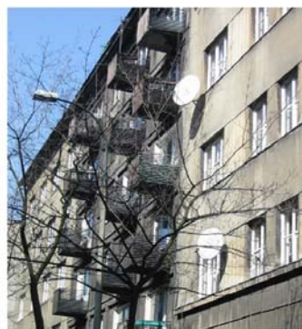
plomba mieszkalna, ul. Mazowiecka
